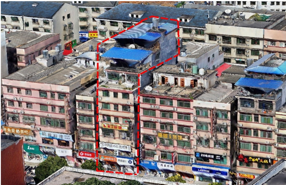
图 4 加层扩建后涉事房屋东南向立面照片
