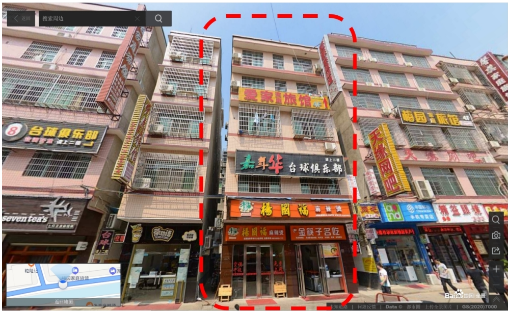
图 3 加层扩建前原自建房南向立面照片
